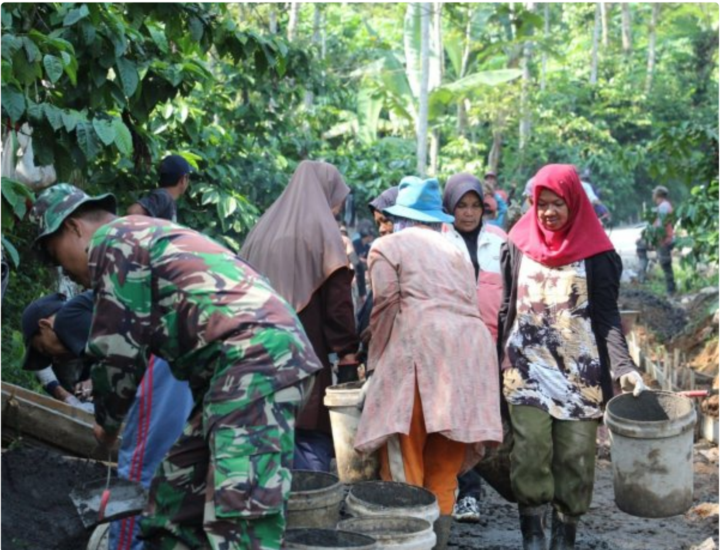
Ibu Ibu Bantu Percepat Pembangunan TMMD
