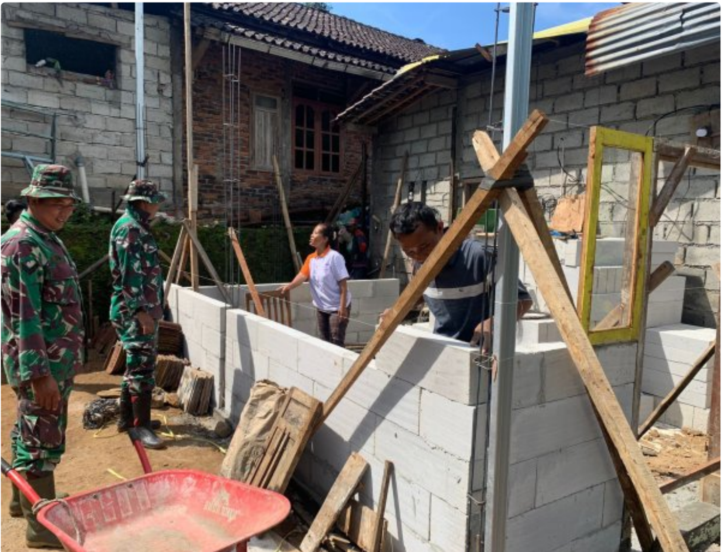
Pemasangan Dinding Menggunakan Herbel
